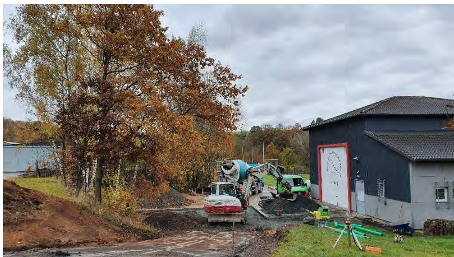
Foto: Die holprige Auffahrt in Höhe des Vereinsheims wurde von der Fa. Balzer aus Dautphetal nun endlich neu und auch barrierefrei gestaltet
