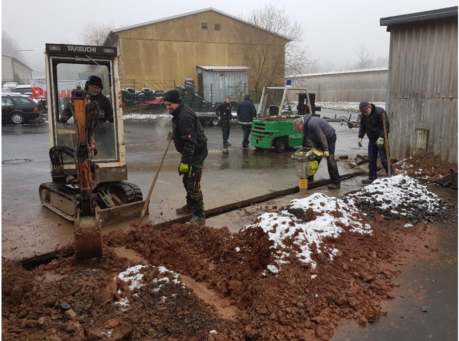
Foto: Der Graben für Glasfaser, Wasser, Strom und Luftdruck konnte von den Aktiven zwischen den Hallen wieder verfüllt werden, trotz Schneewetters
