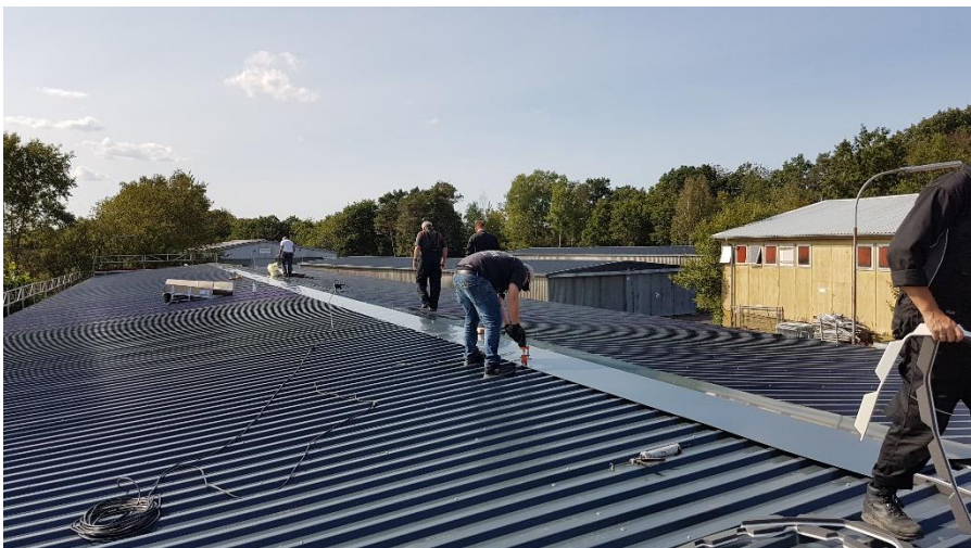
Foto: Das neue Hallendach im Polizeioldtimer Museum ist fast fertig
